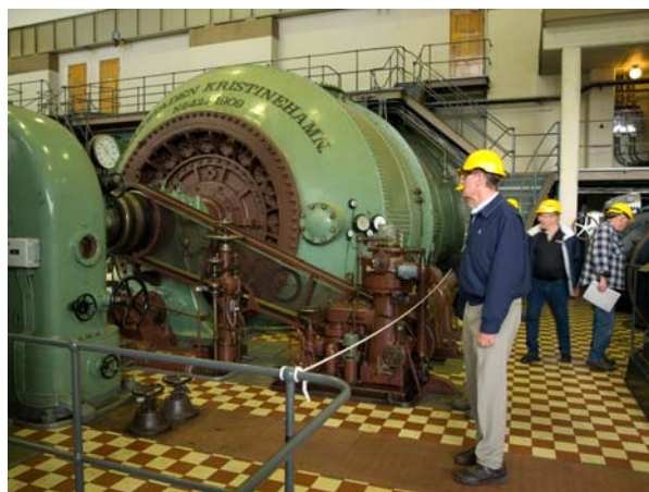
Ett av Olidans 13 turbinaggregat från 1909 som fortfarande fungerar utmärkt med hela 89 procents verkningsgrad.
