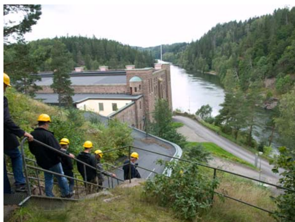
Påväg ner till Olidans kraftstation från 1910. Stationen ligger i Göta älv omedelbart nedströms Trollhättan och fallhöjden är drygt 30 m.
