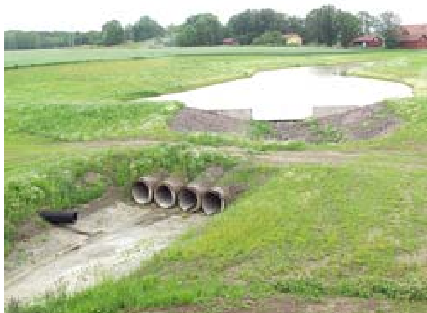
Reningsdamn med överfall i odlingslandskapet. Avsikten är att vattnets uppehållstid ska öka i landskapet för att de naturliga reningsprocesserna ska kunna bryta ner mera av näringsämnena i vattnet.
