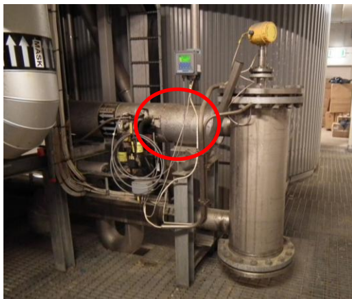
Figur 1: Exempel på intressant mätpunkt (markerad med röd ring) i process efter en mixtank.
