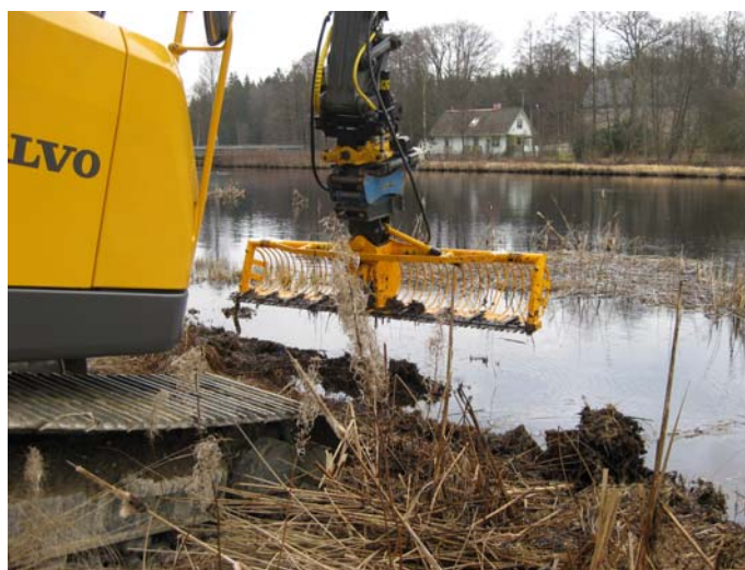
Klippskopan är ett av många specialtillbehör till en grävmaskin. Den gör ett gott arbete vid rensningsarbete i seg rotfilt och täta vassruggar.
