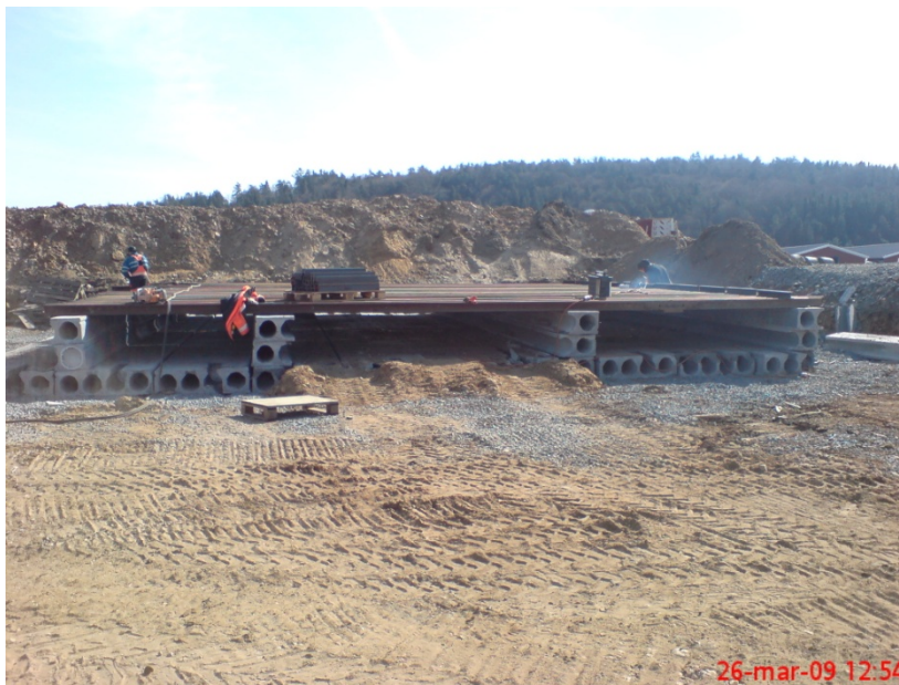
Bild 2. Konstruktionen för eldning i gropen (luft tillförs under eldningsgallret). Foto från BEFAB.
