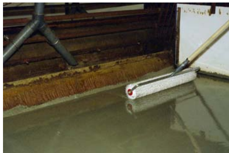
Bild 1. Lagning av betonggolv i ● grisningsavdelningen
