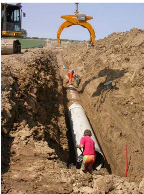
Läggning av vattenledning genom täckdikad åker i Skåne. Foto: Tilla Larsson
