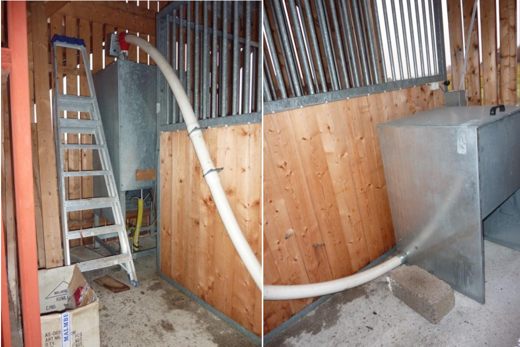
Figur 14. Kraftfoderautomaten fylls med en skruv från behållaren som står på golvet.
